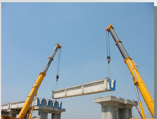
Varo con autogru
