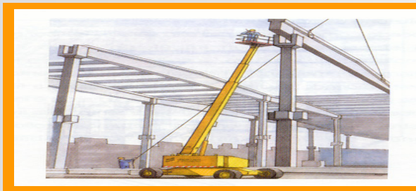
Montaggio elementi prefabbricati
