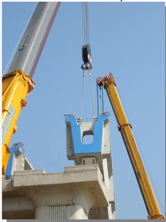
Posizionamento travi in quota
