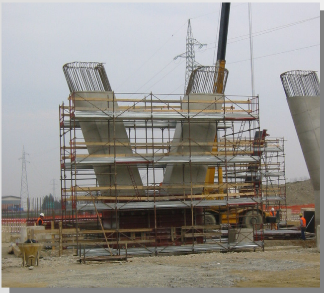
Pila da ponte
