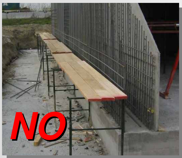
Esempio di ponte su cavalletti non completo
