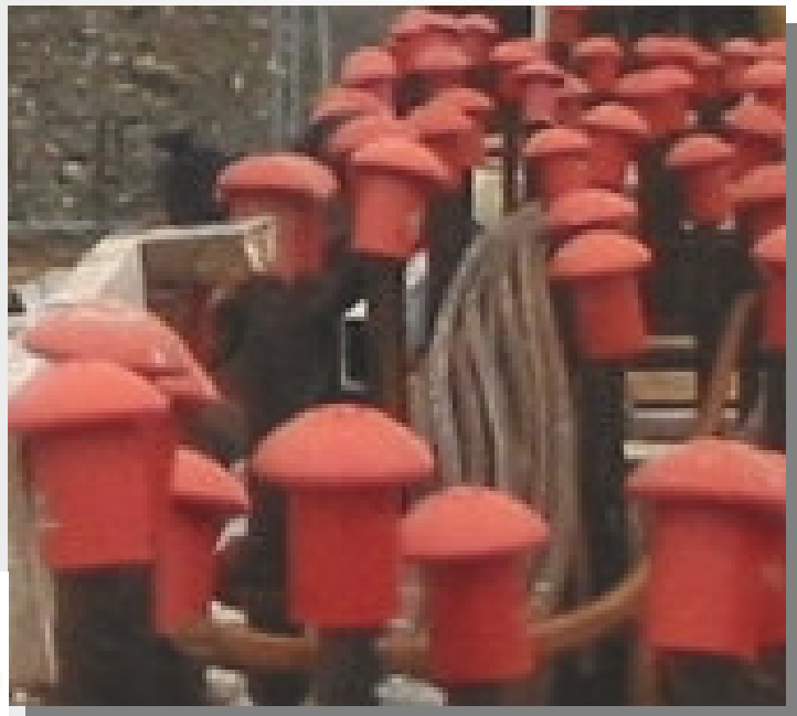
Esempio di protezione dei ferri di ripresa
