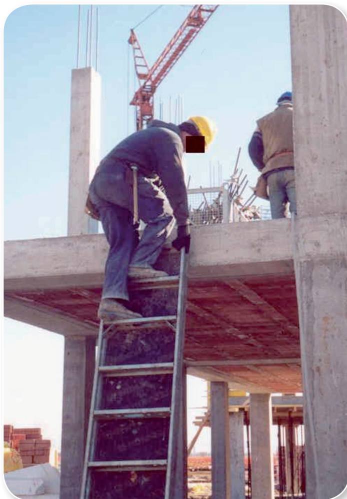
In cantiere ci si infortuna usando scale portatili in maniera non regolare
