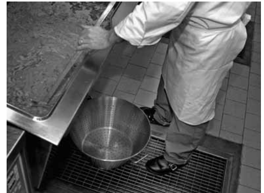
Fig. 1: con i grigliati a filo del pavimento dotati di superficie antiscivolo si evitano incidenti, scivolamenti e inciampii.
