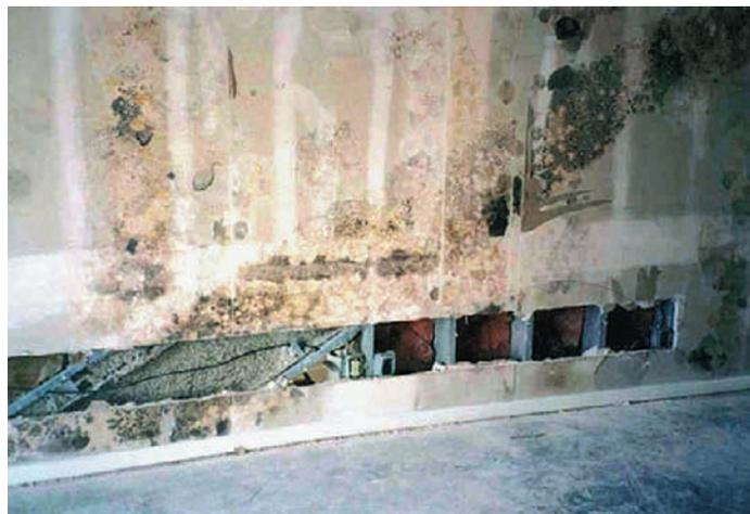
**Fig. 2 - Crescita di muffe dovuta ad intrusione di aria umida.**
